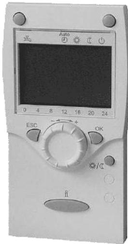
این نمایشگر زیمنس که در داخل ساختمان نصب می شود می تواند با توجه به دمای اتاق دمای دیگ را تنظیم کند به کمک این نمایشگر می توان از داخل منزل سیستم هوشمند موتورخانه را تنظیم کرد. این وسیله به دو صورت با سیم (wired) و بدون سیم (wireless) به کنترلر وصل شود.
